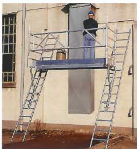
Reparaciones de canalones y chimeneas son muy fáciles de realizar con el travesaño VARIO de RUX-MOBILLO.
